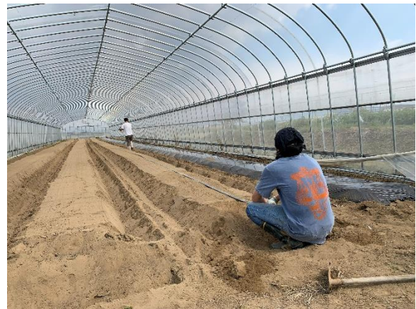
（写真1：農家さんのハウスでの作業風景。畝を立て、灌水チューブを敷いてから、マルチを貼る）
